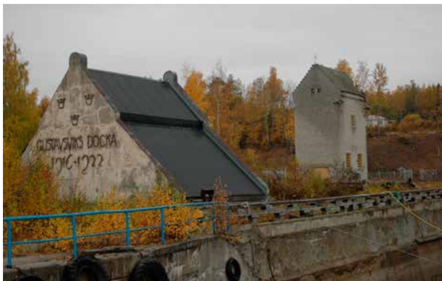
Pumphuset, till vänster, samt transformatorhuset, oktober 2013. Foto: Linnea Tidäng, Länsstyrelsen Västernorrland.
