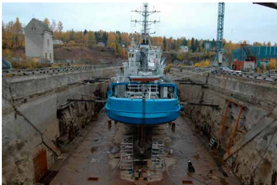
KBV 181 från Umeå i Gustafsviks docka för reparation av roder. Närmaste dockningsmöjlighet fanns annars i Åbo. Foto: Linnea Tidäng, Länsstyrelsen Västernorrland, oktober 2013.
