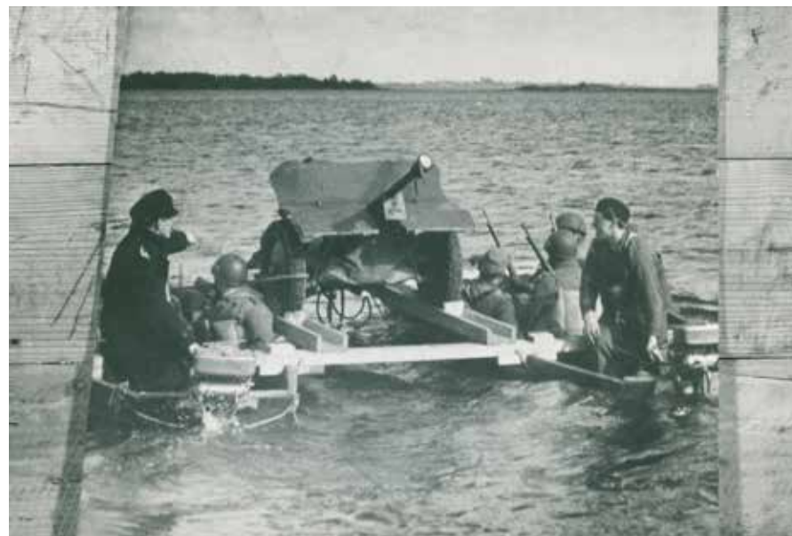
Den danska flottiljen samövade med den danska brigadens armésoldater som bl.a var förlagda i Ronnebybrunn. Här har man med plankor kopplat samman två svenska överskeppningsbåtar för att kunna landsätta en mindre infanterikanon. Foto: Frihedsmuseets fotoarkiv.
